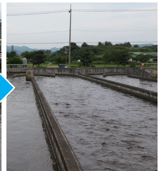
개선 후 OxyStar Aerators 15.0 kW, x 2대 교체 운전
